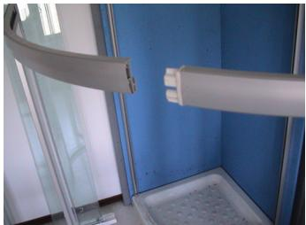
**I** Unire i due lati della cabina tramite le apposite giunzioni. Fissare le parti tramite viti in dotazione 4,2x9,5.
