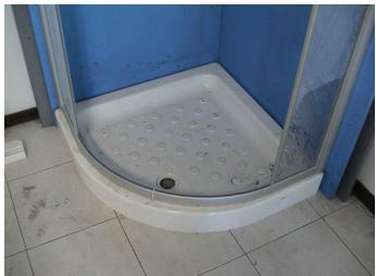
**I** Posizionare la cabina sul piatto doccia. Estendere la cabina alla misura occorrente agendo sulle viti dei profili di fissaggio a muro.
