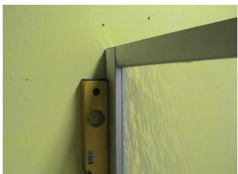
**I** Sistemare in perfetto appiombo i profili di fissaggio a muro della cabina, tracciare e forare (punta Ø6 mm).
