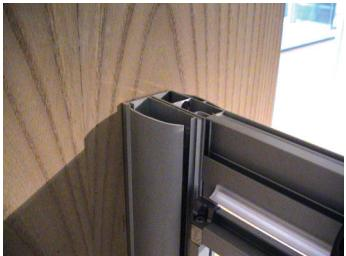
**I** Inserire profili copritive ai montanti a muro e tappi coprifilo (pag 35).
