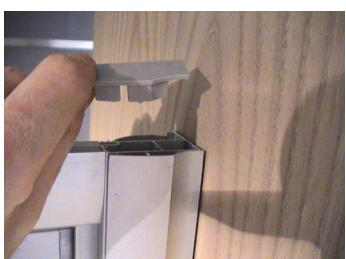
**I** Avvitare le due boccole al profilo della porta prefabbricato tramite viti autofilettanti in dotazione (3,5x9,5).
